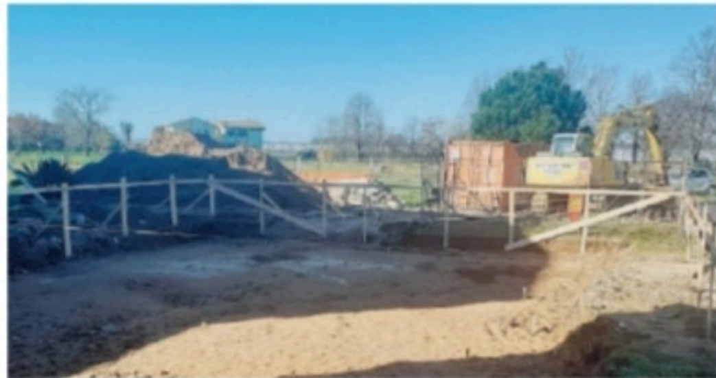
L'area di cantiere
